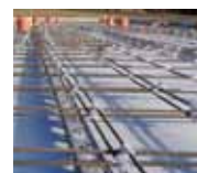
Kompozitní síť tabule armatura \phi 6 - 12 mm/ oko 150x150 - 200x200
