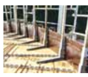
Al-fix instalovaný na bednění
