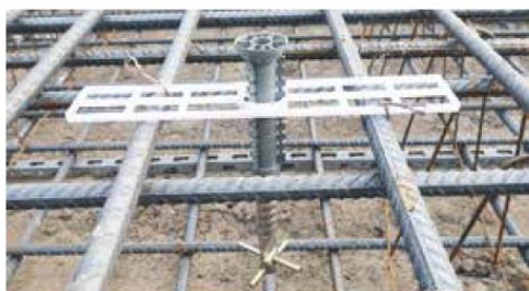
Při použití na stropní nebo podlahové panely je nerezová kotva V2A UNI přípevněna k horní výztuži pomocí montážní desky.
