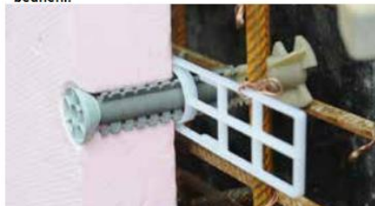
Použití plastové kotvy UNI s montážní deskou a prodlužovacím pouzdrům pro izolační vložky v bednění.
