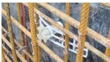
Kužel je pomocí montážní desky optimálně přitlačen k bednění.
