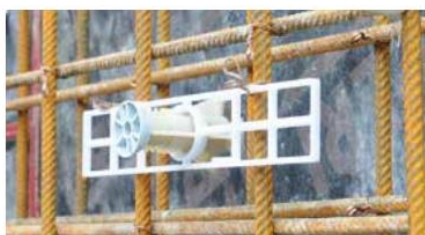
V případě vnitřního bednění, sloupy nebo ocelového bednění se pomocí výztužné desky přípevní na výztuž
