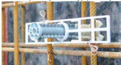
Při použití s montážní deskou a prodlužovacím pouzdrům se zvětší hloubka a tím zaručené přípustné pracovní zatížení zvýší na 4 500 kg (45 kN).
