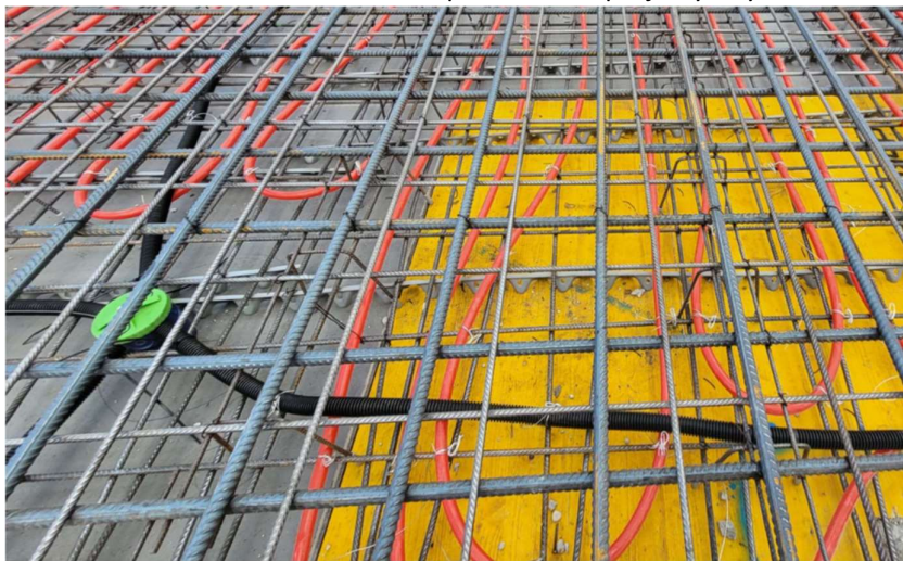
Obrázek 7: Hotová výztuž desky s distančními klecemi s plastovou podstavou
