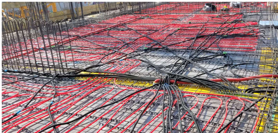
Obrázek 1: Spodní výztužná vrstva podlahové desky v bytové výstavbě
