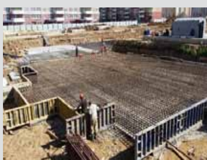
Moskva 2016 – Armování základové desky v kombinaci s železem pro 17-ti podlažní bytový dům
