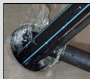
Nastříkejte hmotu Flex 2000
