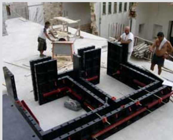
Geopanel - lehké plastové bednění, možná ruční manipulace
