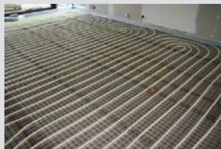
Betonáž vytápěné podlahy
