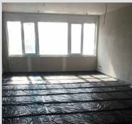
Betonáž – dovyztužení vysoce zatížené podlahy
