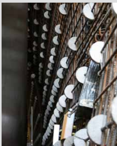
vnitřní ostění tunelu
