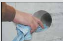
Odstraňte z jádrového otvoru prach
