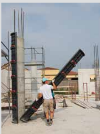
Geotub - pr. 25 - 100 cm, délka segmentu 60 cm
