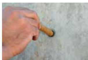
Zasuňte ucpávku do prostoru po spínání
