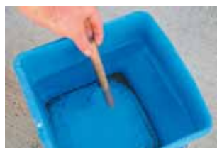
Ucpávku ponořte do vody (u protipožárních stěn do vhodného roztoku)
