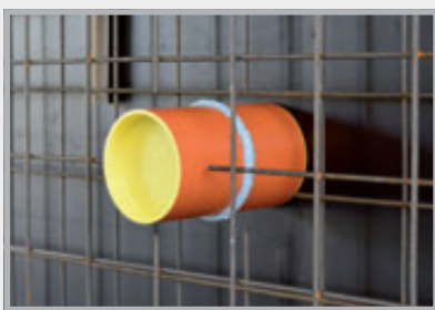
Prostup připravený pro betonování
