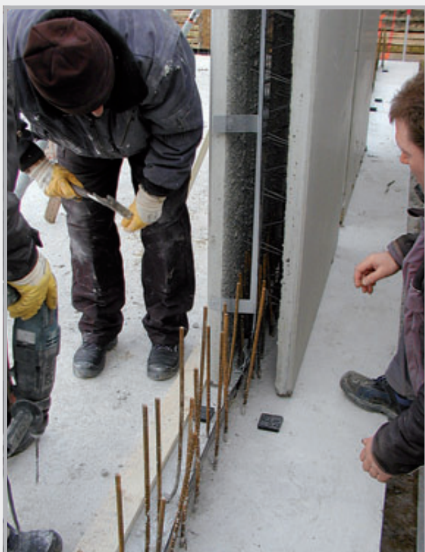
Instaluje se dutá stěna, při tom těsnicí plech MASTER vytváří utěsnění základů/zed'.
