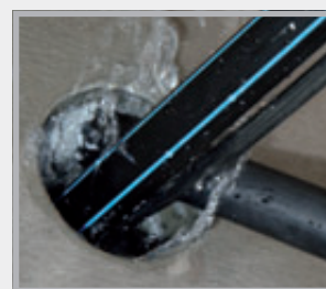
Nastříkejte hmotu Flex 2000
