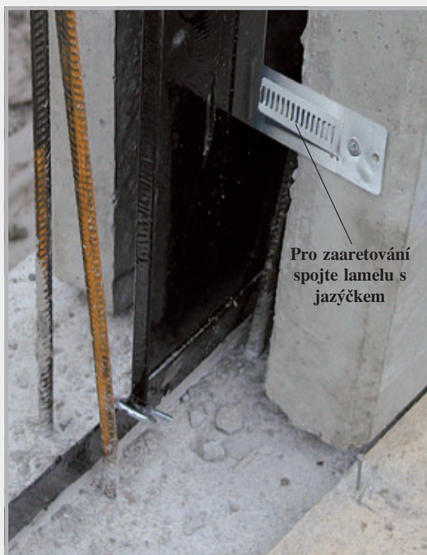
Instaluje se dutá stěna, při tom těsnicí plech MASTER vytváří utěsnění základů/zed'.
