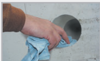
Odstraňte z jádrového otvoru prach
