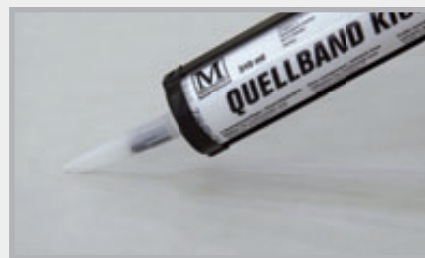
Nanášení lepidla na čistý podklad
