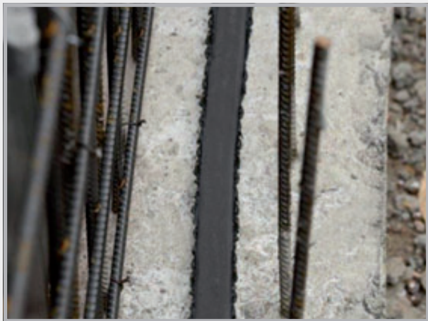
Instalace pomocí lepidla na bobtnající pásy
