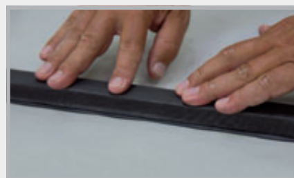
Bobtnající pásek zatlačte do lože lepidla
