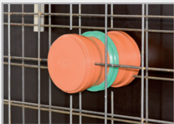
Čelní pohled, nainstalovaná potrubní průchodka
