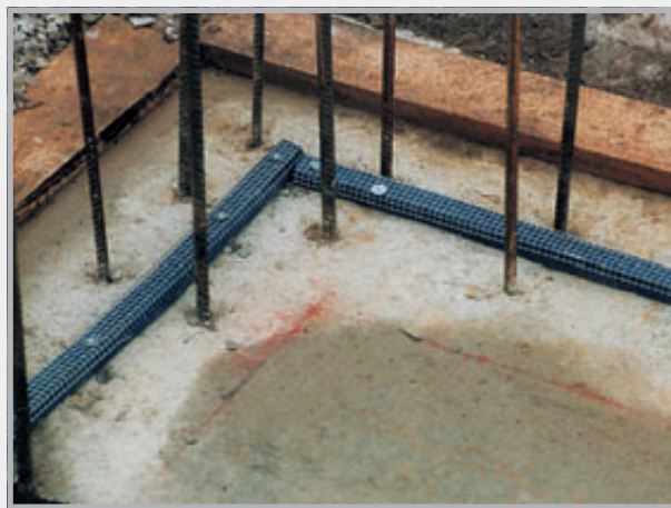
Pokládka pomocí upevňovací mřížky a hřebíků
