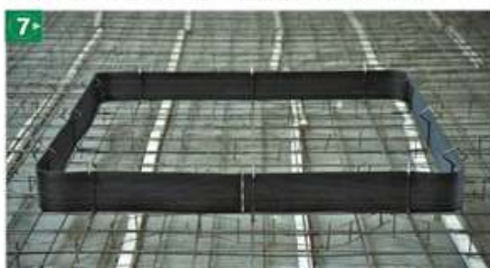
Těsnící pás s lepeným spojem
