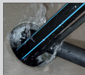
Nastříkejte hmotu Flex 2000
