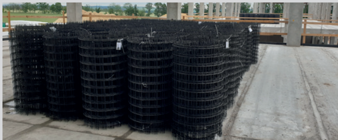
Použití kompozitní sítě pro vyztužení potěru na prefabrikovaných panelech
