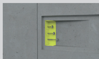
Zasunutí 3 systémových šroubů do vodítky šroubů
