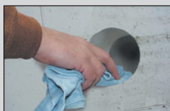
Odstraňte z jádrového otvoru prach
