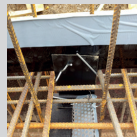
Detail propojení ABS a BK plech
