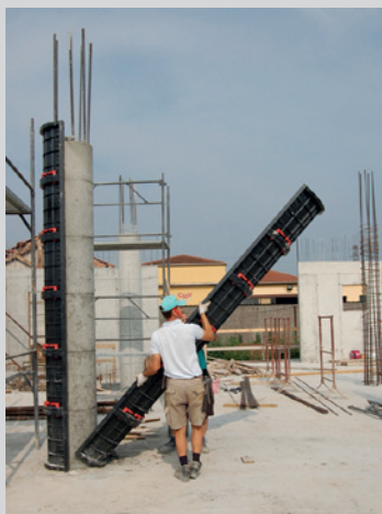
Geotub - pr. 25 - 100 cm, délka segmentu 60 cm
