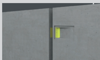
Vyrovnání stěnových prvků pro montáž
