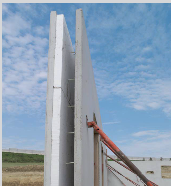
Isolink - sendvičová stěna před betonáží
