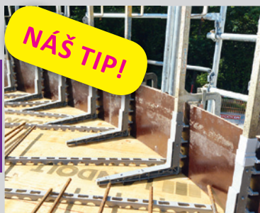
AL-FIX instalovaný na bednění
