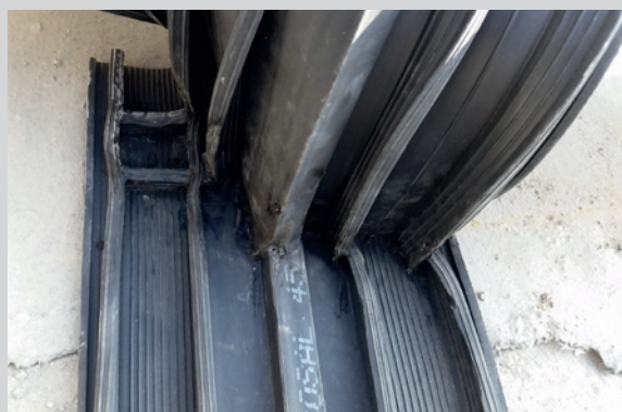
Ukázka svárů dilatačních pásů
