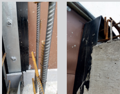
Připojení konstrukce pomocí pásnice.
