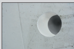
Trvale chráněn epoxidovou pryskyřicí PROTECT
