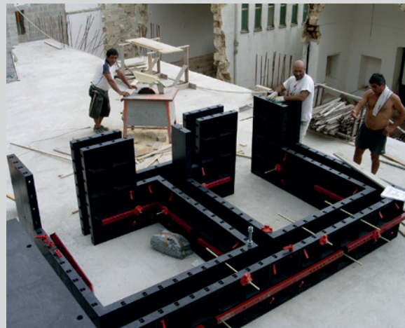
Geopanel - lehké plastové bednění, možná ruční manipulace
